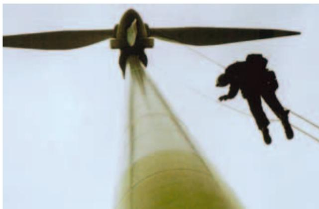
Seit August 2000 drehen sich die Windräder am Fuchsenbühel. Nach vier Jahren Betriebszeit erfolgte eine Reihe behördlich vorgeschriebener Prüfungen. Die Inspektion der Rotorblätter und des Turmes mittels Seiltechnik bot spektakuläre Anblicke (siehe Fotos) Die Überprüfungen ergaben, dass sich die Windkraftanlagen in sehr gutem Zustand befinden. Dies ist vor allem deshalb von Bedeutung, da die Anlagen rund um das Abfallwirtschaftszentrum angeordnet sind.
