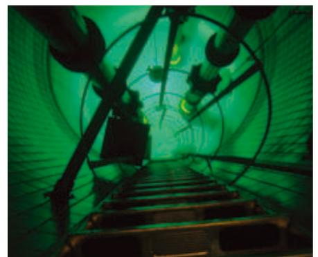
Schacht eines Trinkwasserbrunnens in der Stockerauer Au: Tiefe=12m, Breite=4m
